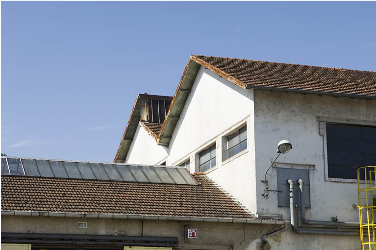
Toiture d'un magasin industriel.
