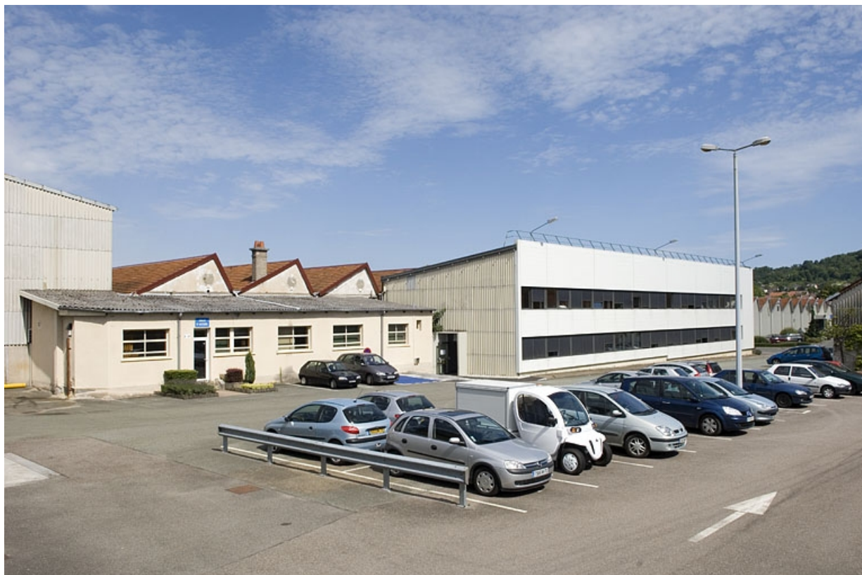
Atelier en rez-de-chaussée et bureaux.
