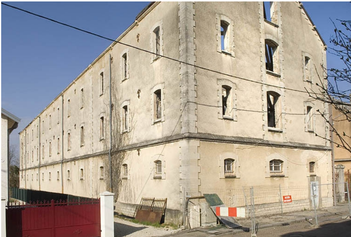
Aile ouest incendiée vue de trois quarts.
