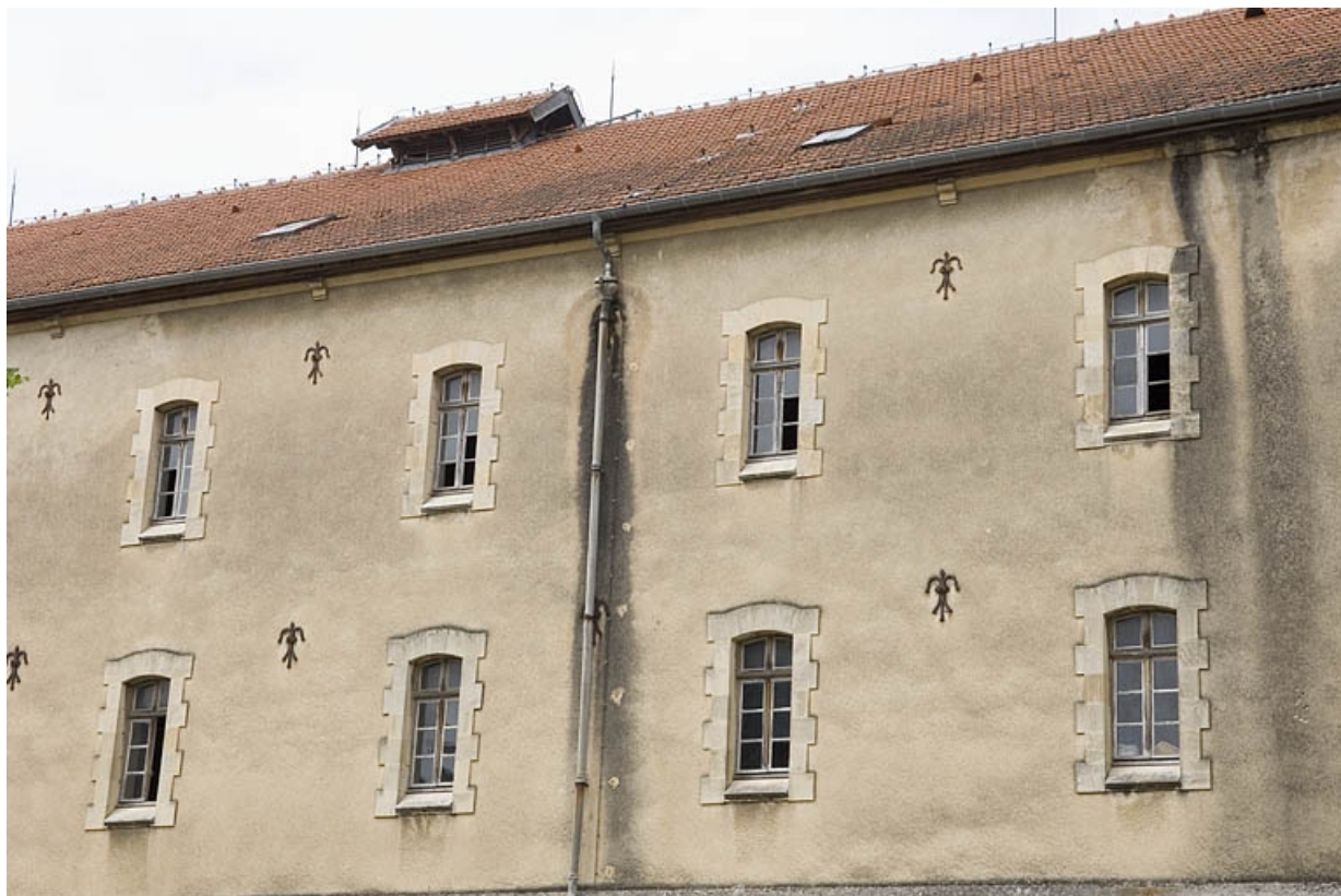
Etages supérieurs du corps central.
