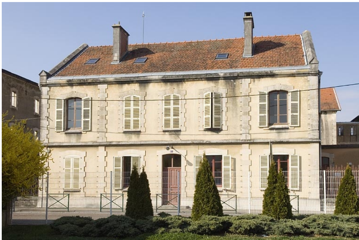
Bâtiment des bureaux. Façade antérieure.
