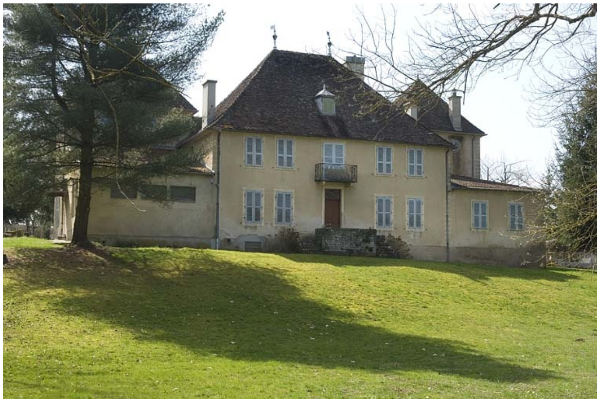
Façade postérieure du logement patronal.
