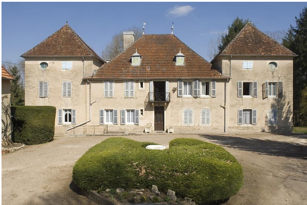
Façade antérieure du logement patronal.
