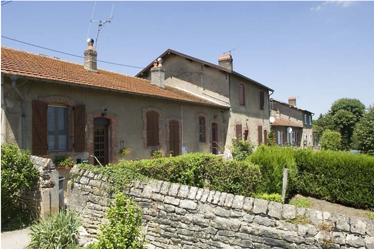
Logements ouvriers contigus. Vue depuis le sud-est.
