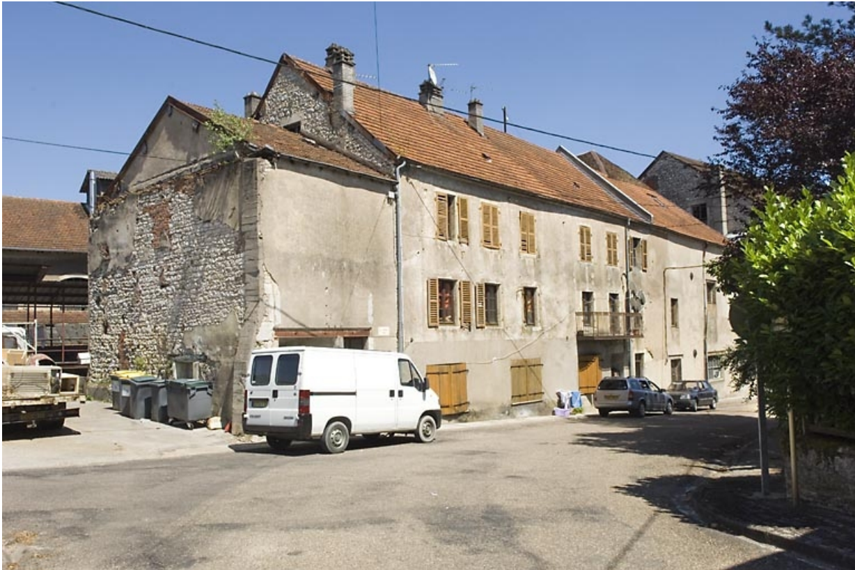
Bâtiment des bureaux et logement.
