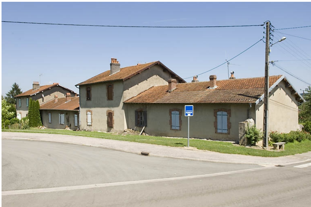
Logements ouvriers contigus. Vue depuis le sud.
