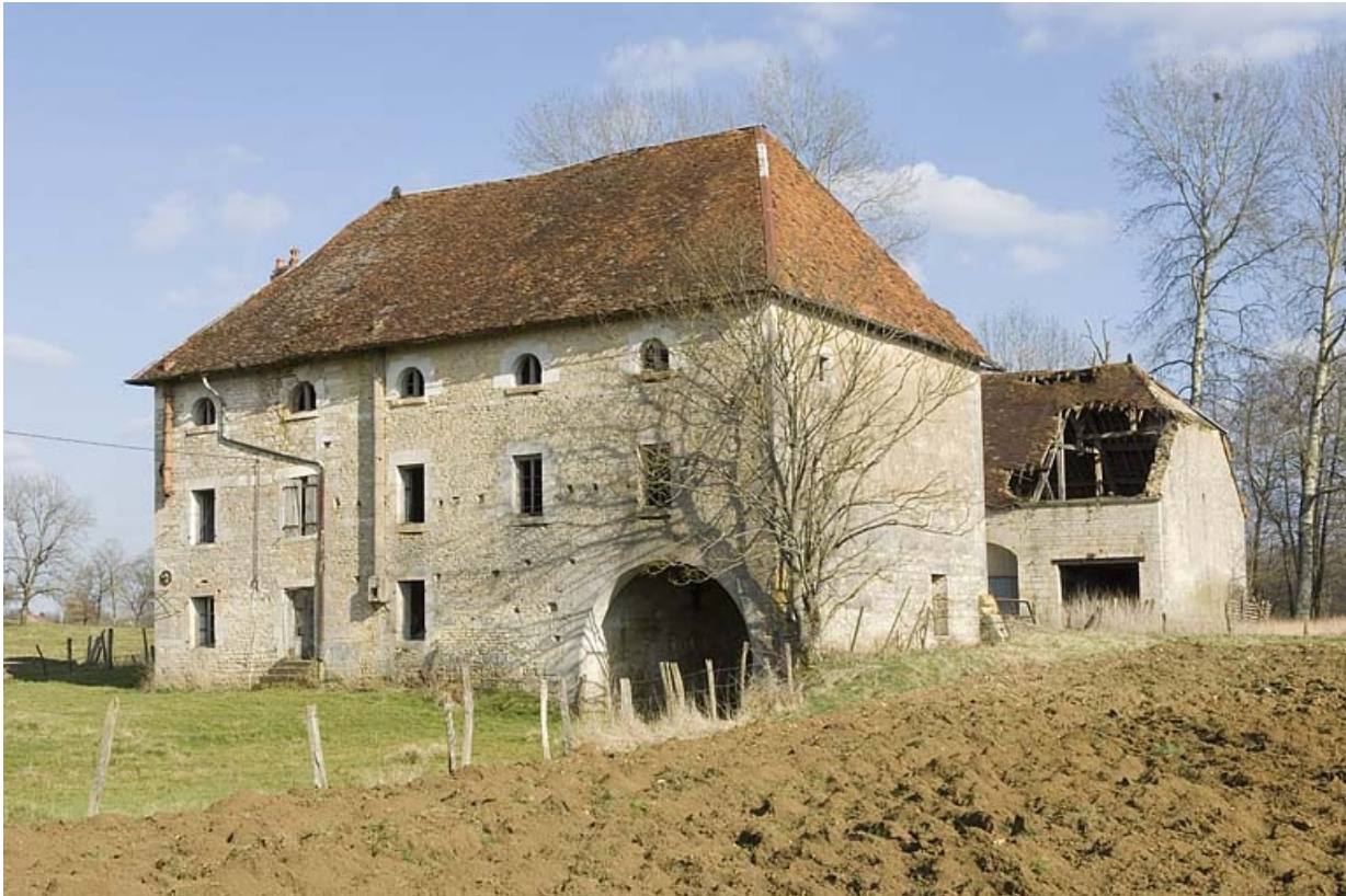
Vue depuis l'ouest.
