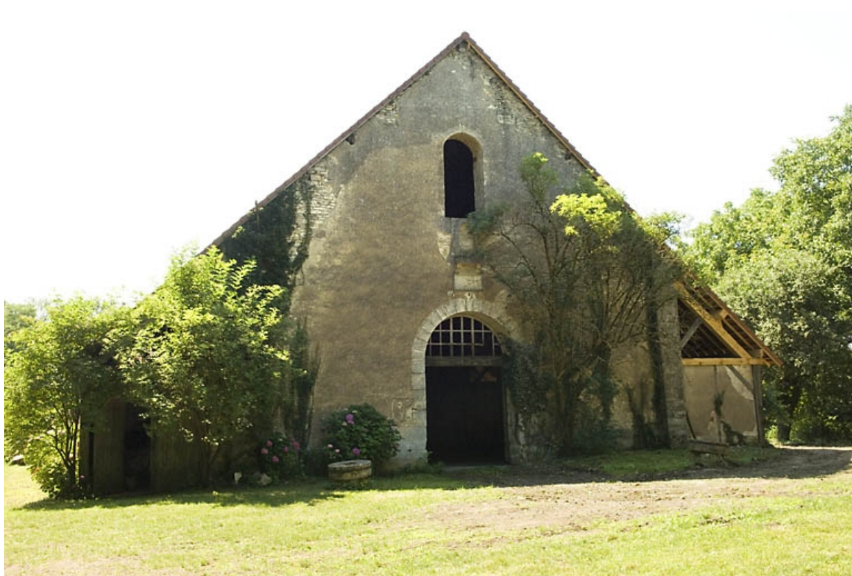
Mur-pignon nord de la halle à charbon.
