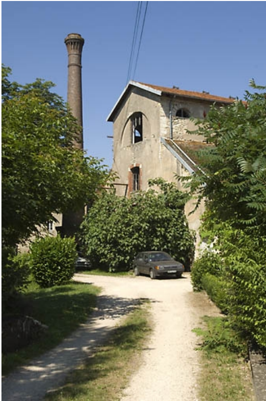
Vue du haut fourneau depuis l'entrée.
