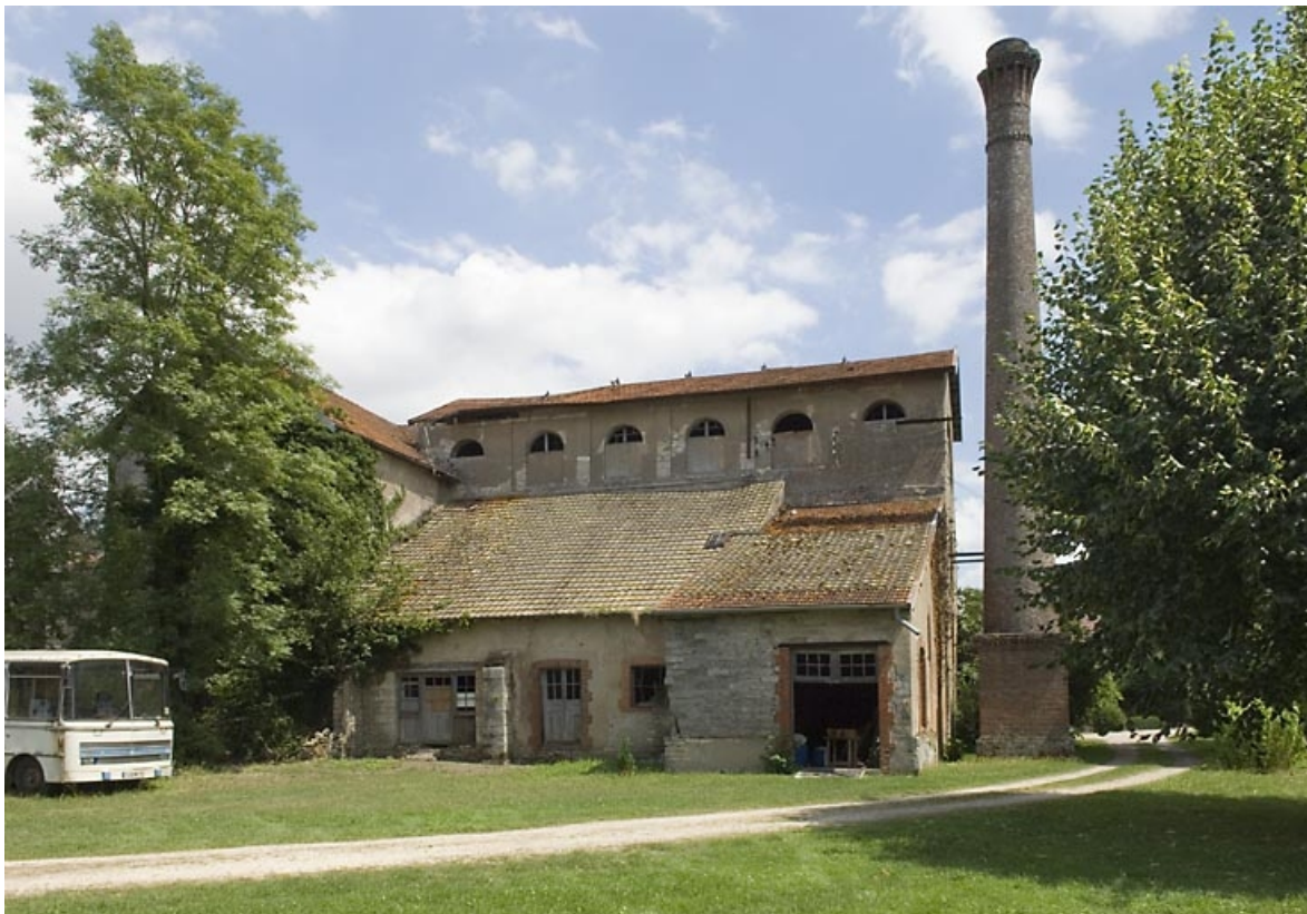
Elévation ouest du haut fourneau.
