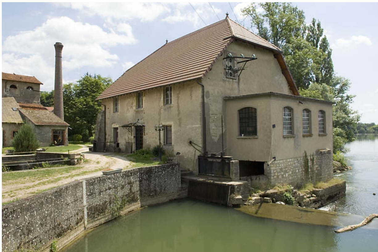
Moulin reconverti en centrale hydroélectrique.
