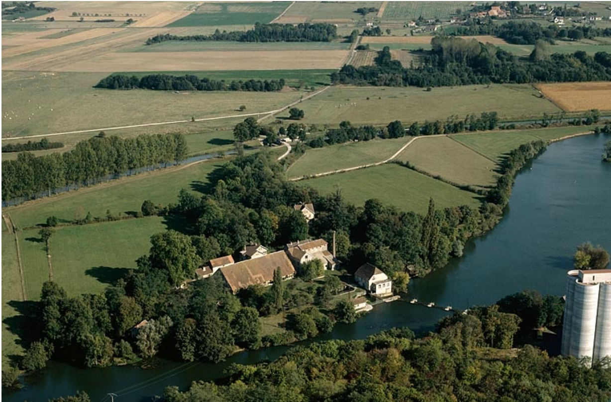
Vue aérienne depuis le nord-ouest en 1989.
