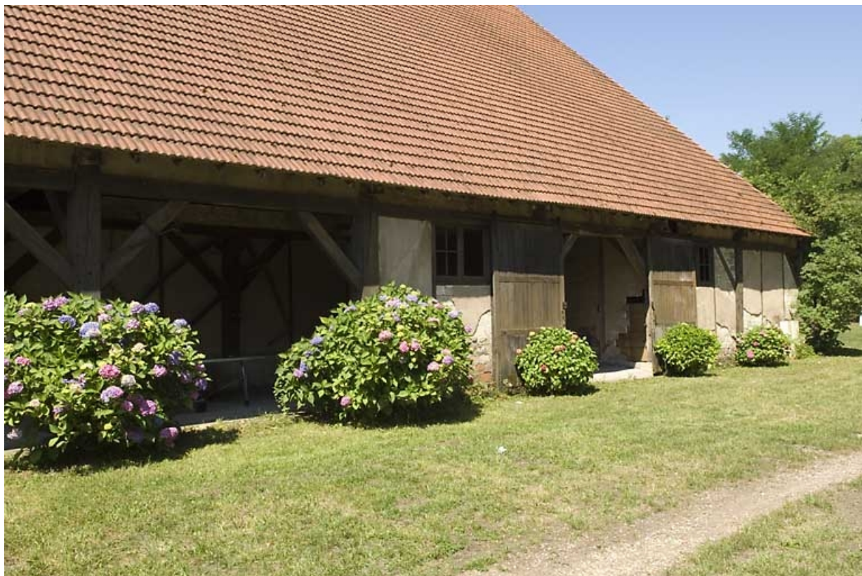
Extrémité nord de la halle à charbon.
