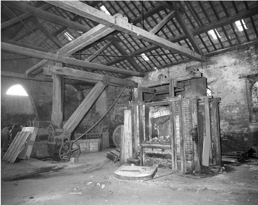
Vue d'ensemble de l'atelier de fabrication en 1981.
