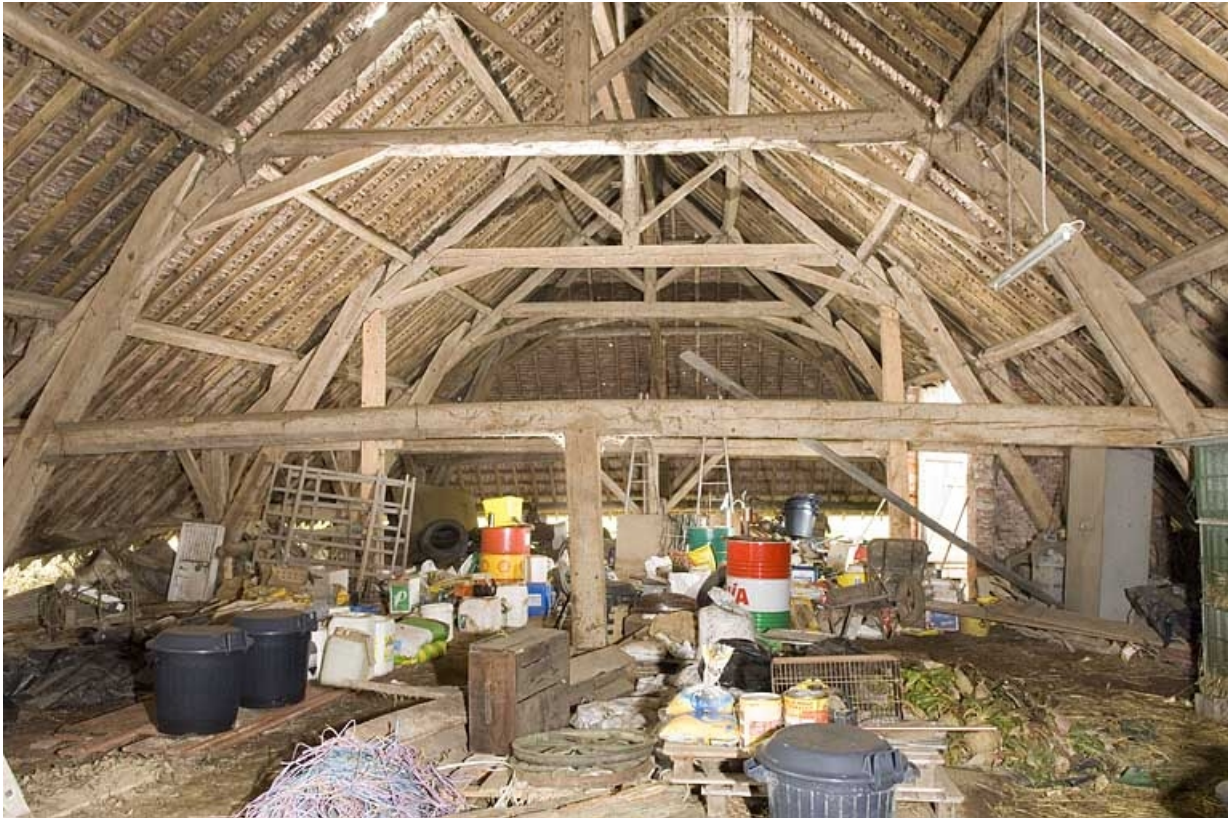
Séchoir. Partie sud de la charpente.
