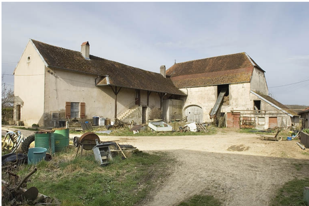
Vue de la ferme depuis l'est.
