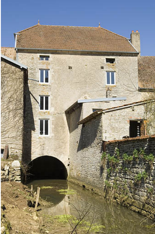
Façade postérieure depuis le bief d'aval.
