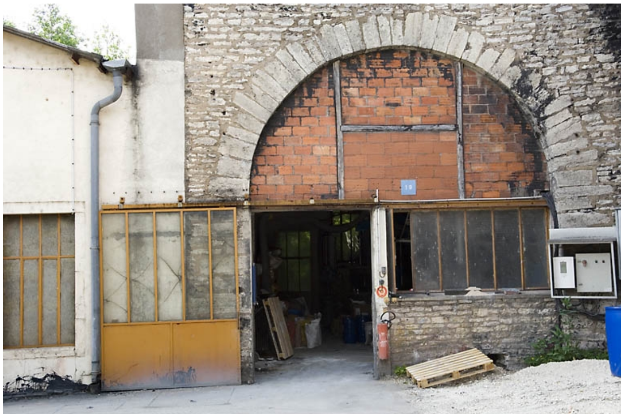
Vestiges du bâtiment du haut fourneau (?).
