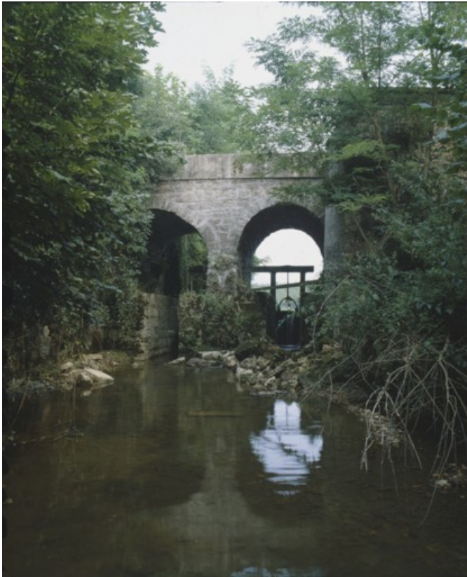
Canal de décharge en 1989.
