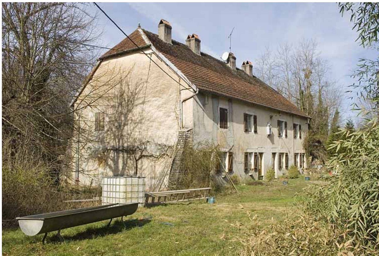
Logement d'ouvriers. Vue de trois quarts.
