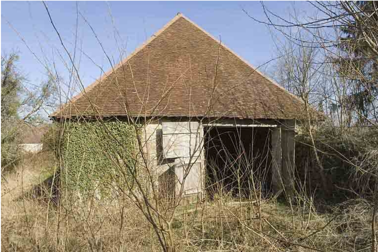
Pignon sud de la halle à charbon.
