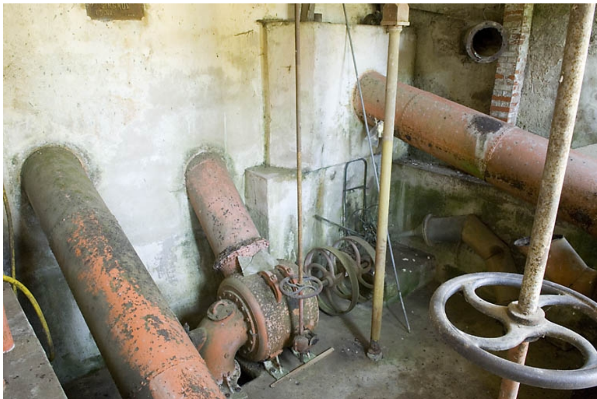
Intérieur du bâtiment d'eau.
