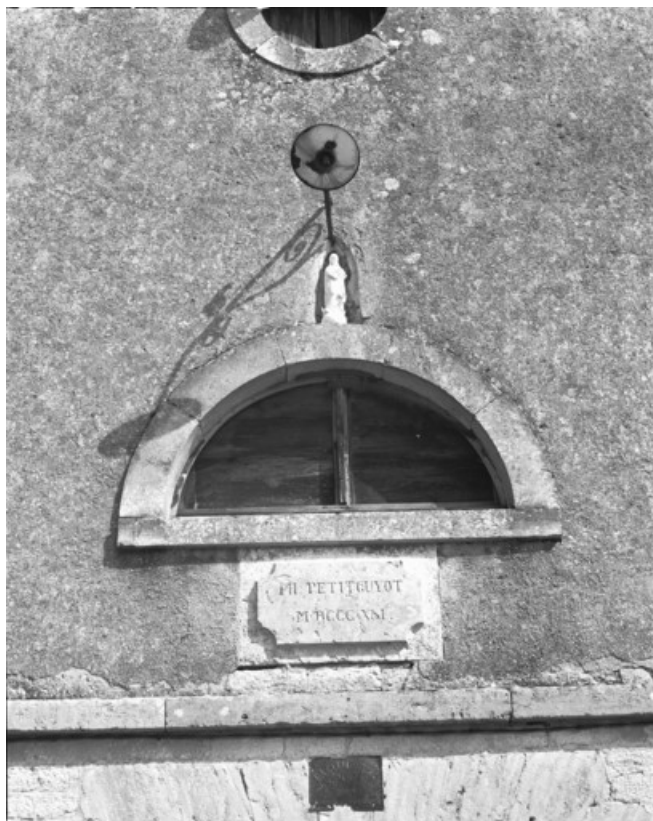
Détail du pignon du haut fourneau en 1989.
