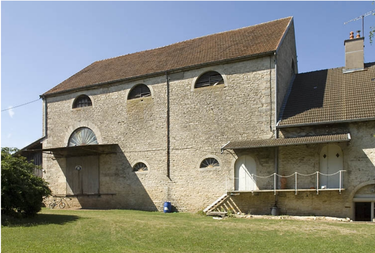
Façade sud du haut fourneau.
