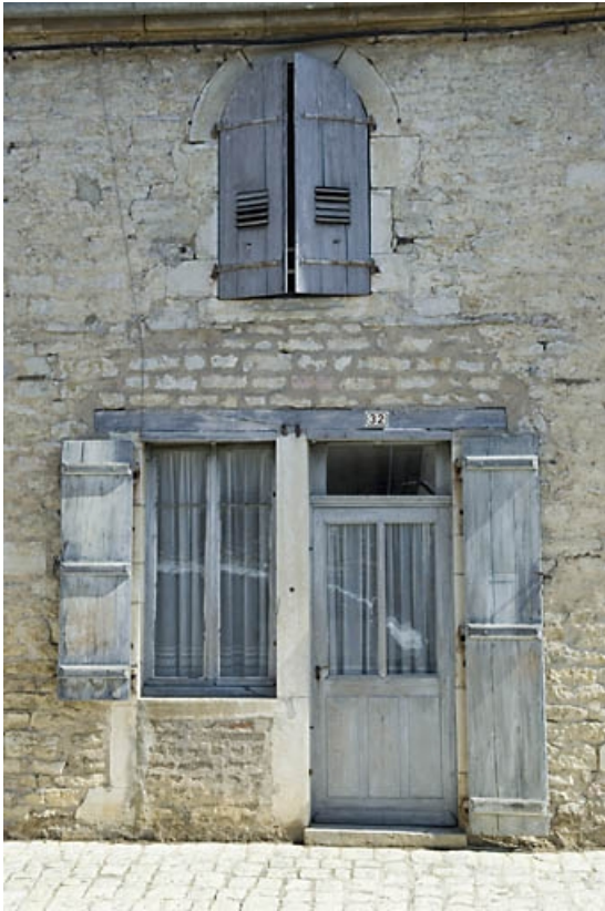
Travée de la façade du logement ouvrier.
