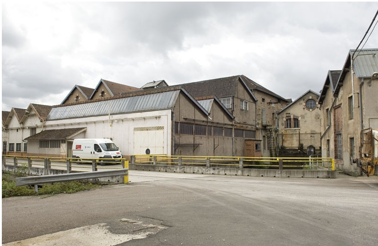
Atelier de fabrication (papeterie) et bâtiment d'eau.
