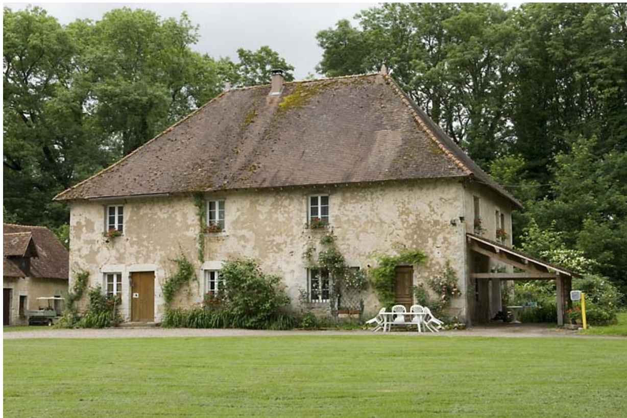
Logement patronal vu de trois quarts droite.
