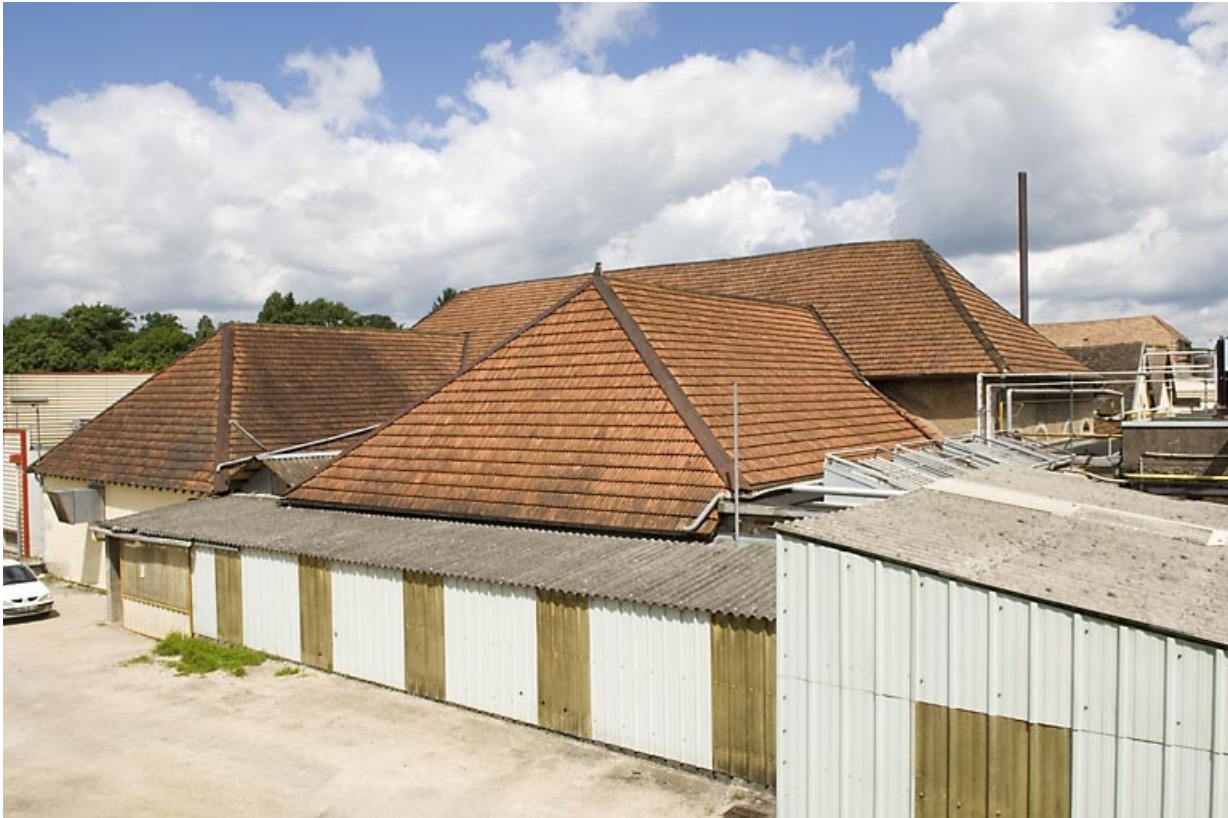
Halle de fonderie depuis le sud-est.
