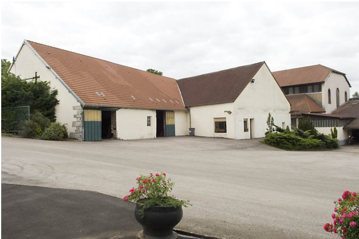
Magasin industriel et atelier de moulage.
