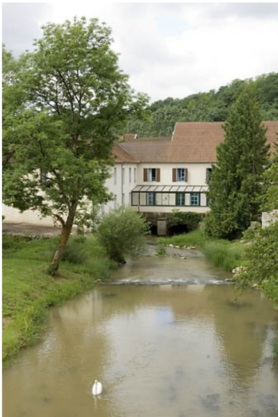
Bief d'amenée à l'usine.
