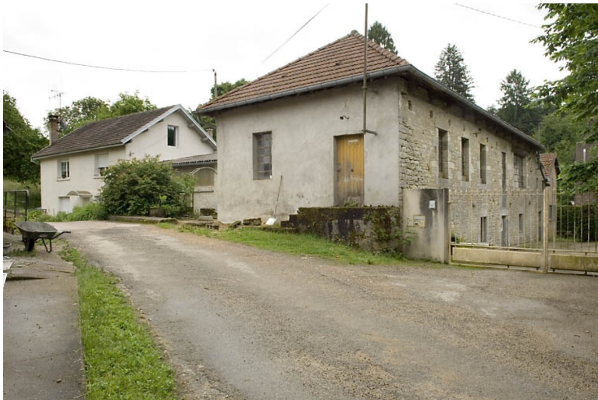
Vue d'ensemble depuis l'entrée.
