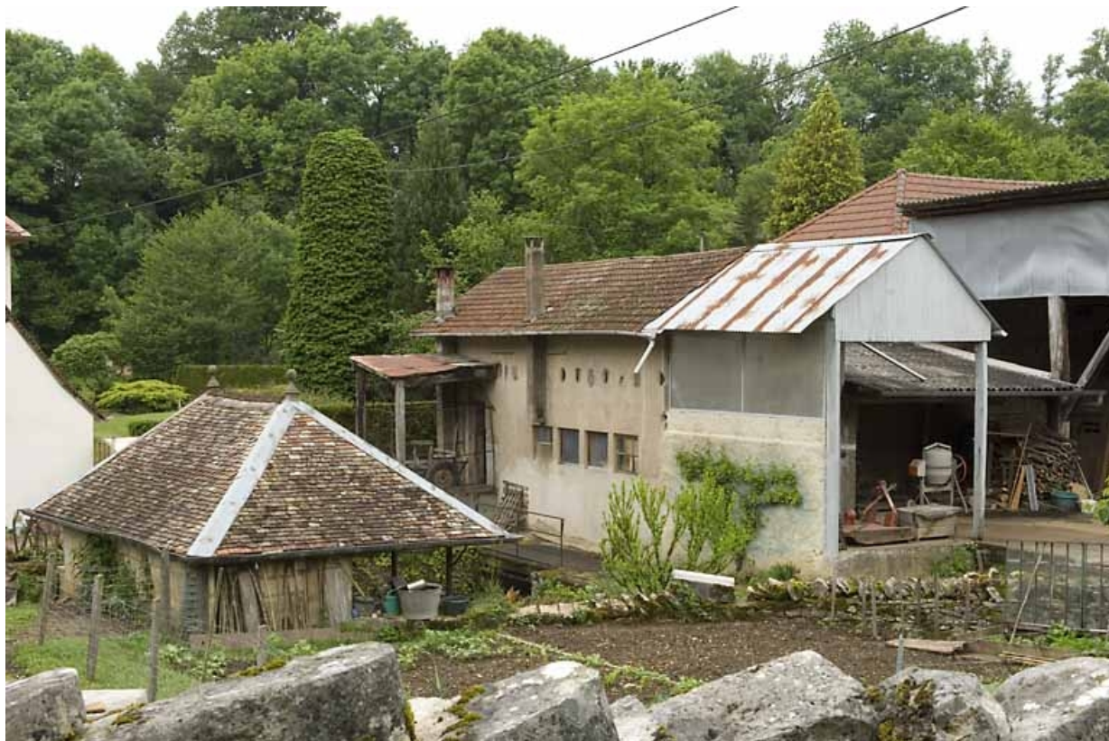
Les bâtiments industriels depuis le sud-est.
