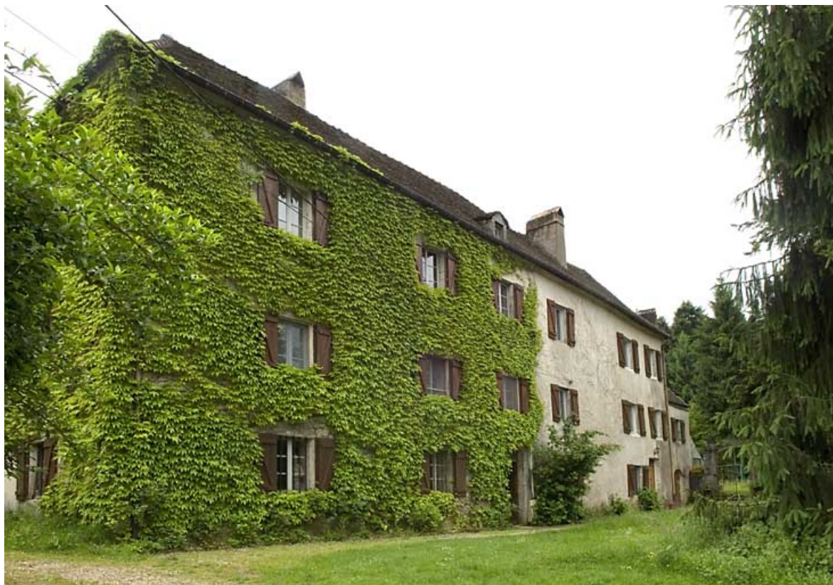
Logement patronal. Élévation ouest.
