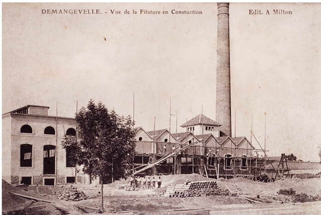
Demangevelle. - Vue de la filature en construction.
