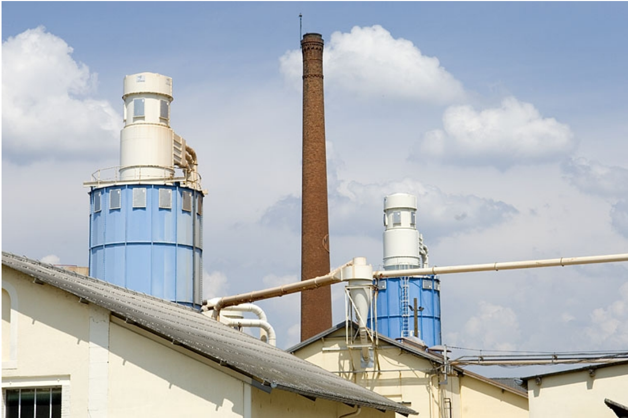
Silos et cheminée depuis le sud-ouest.
