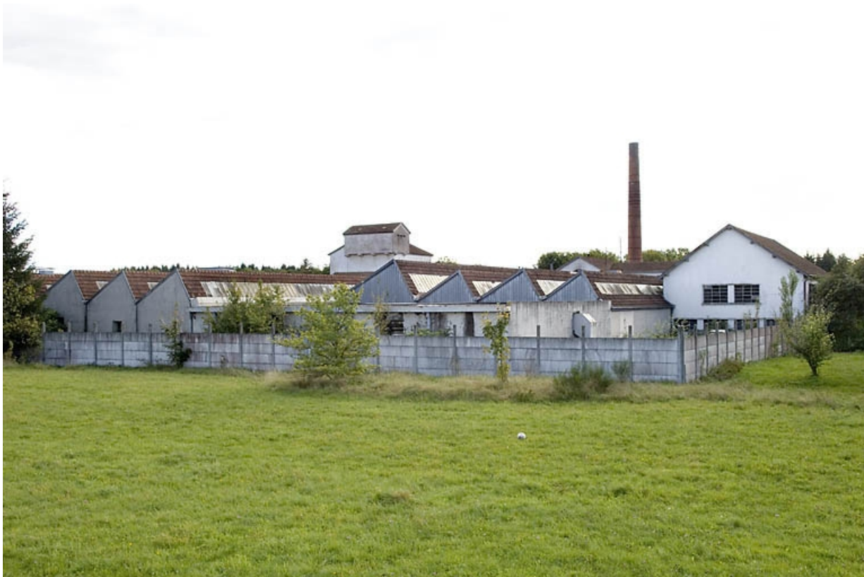
Vue rapprochée depuis le nord.
