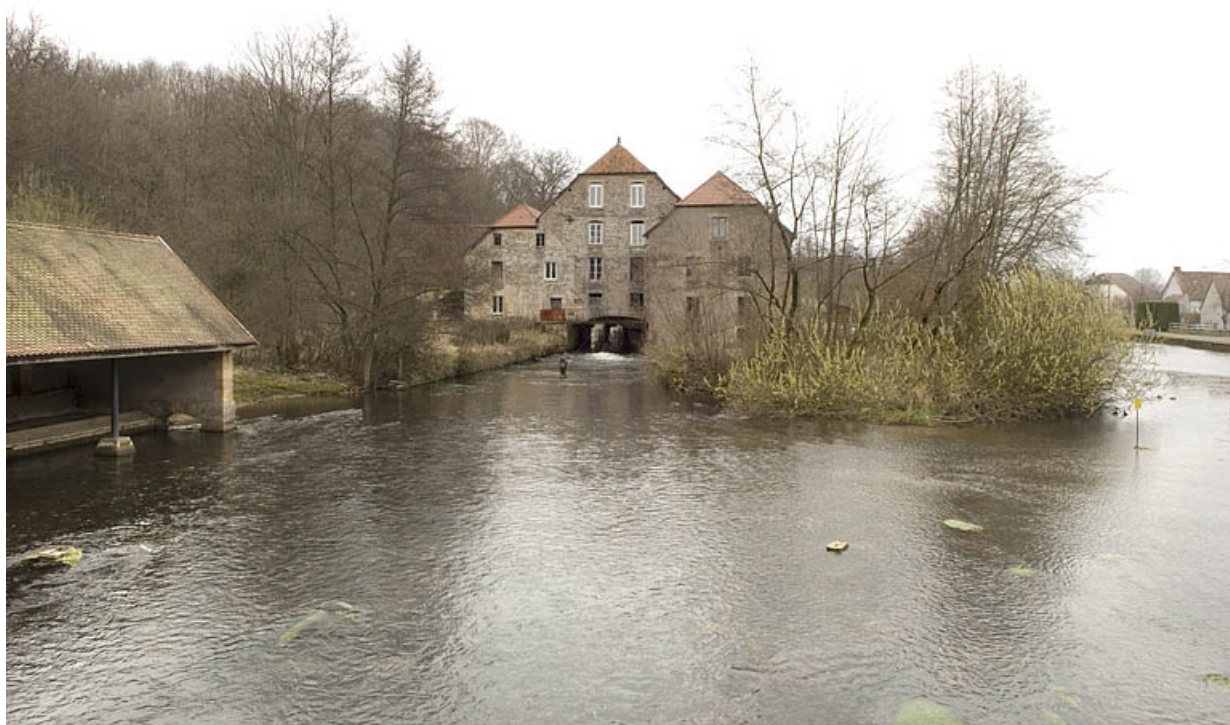
Vue d'ensemble depuis le pont.
