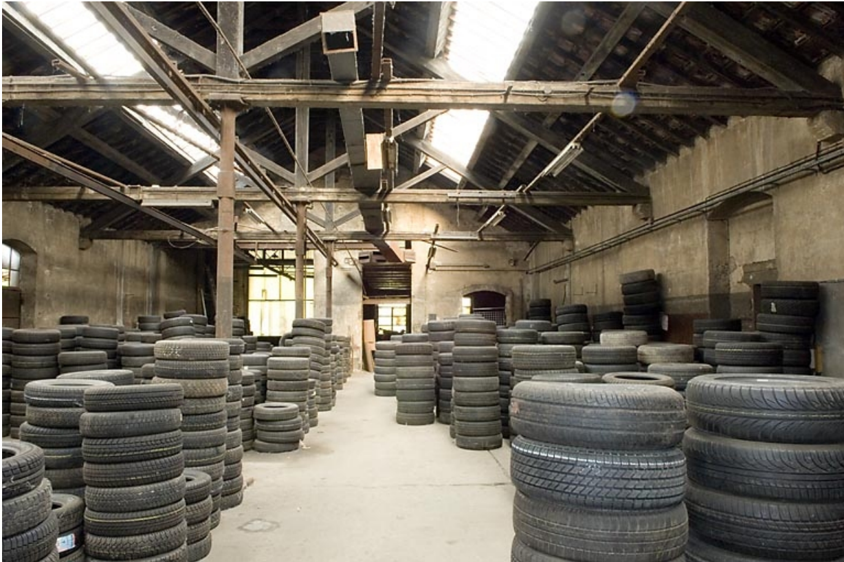
Charpente et couverture de l'atelier de fabrication.
