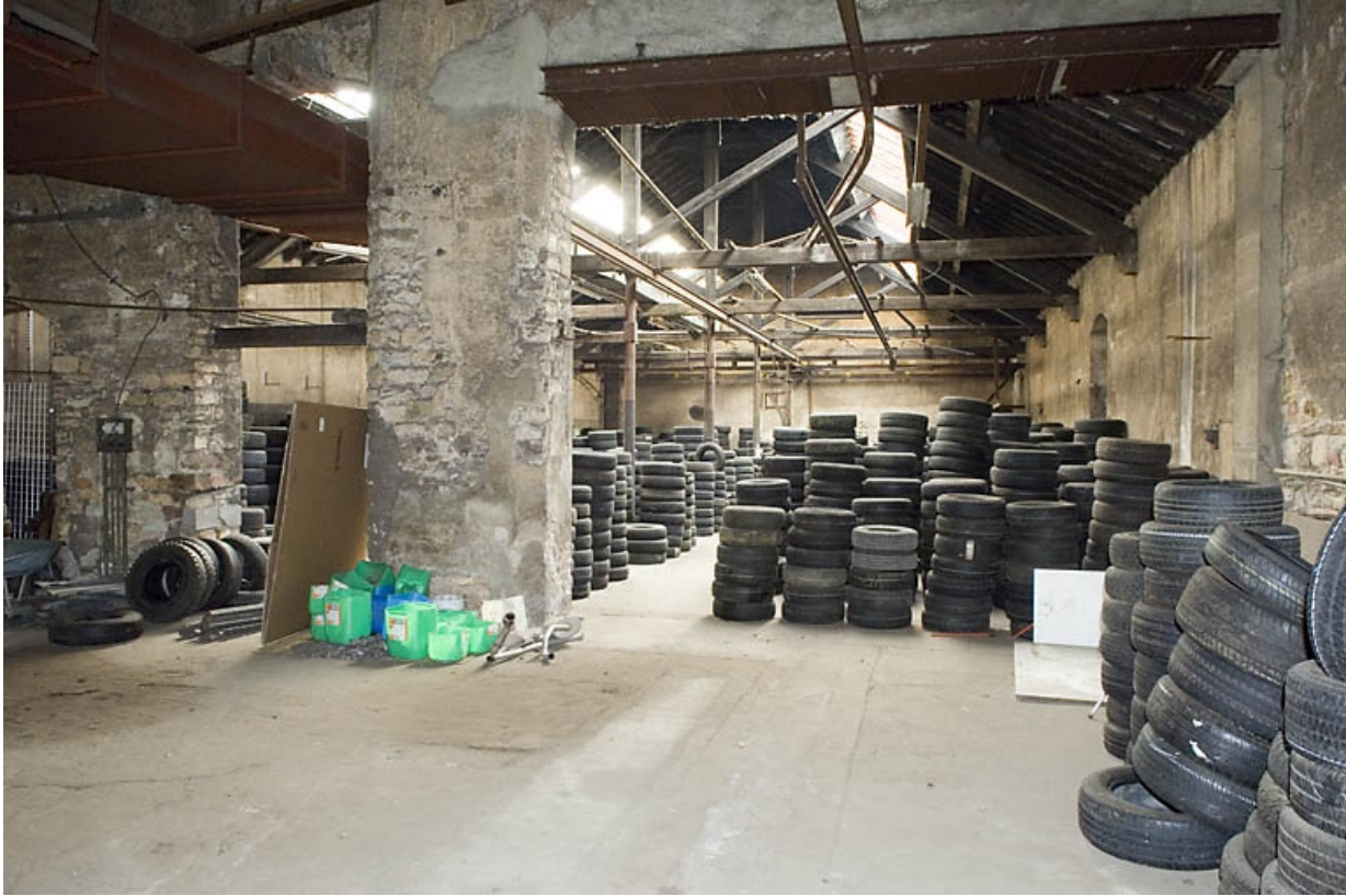
Vue intérieure de l'atelier de fabrication.
