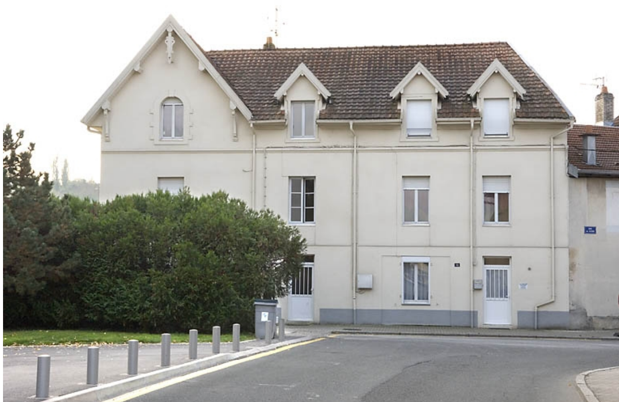
Logement ouvrier (?). Vue de face.
