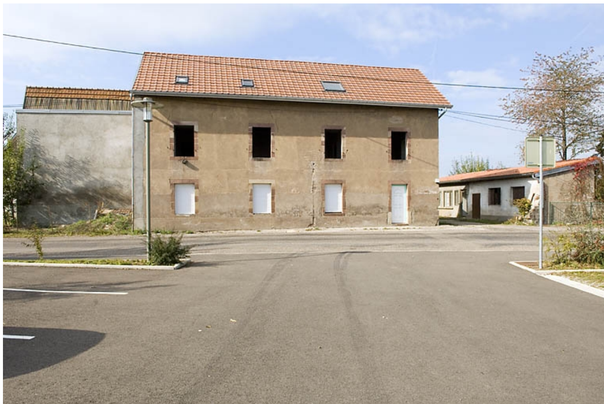
Ancien atelier de fabrication (?). Façade sur rue.
