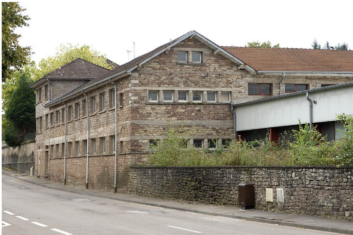
Atelier de fabrication. Vue de trois quarts.
