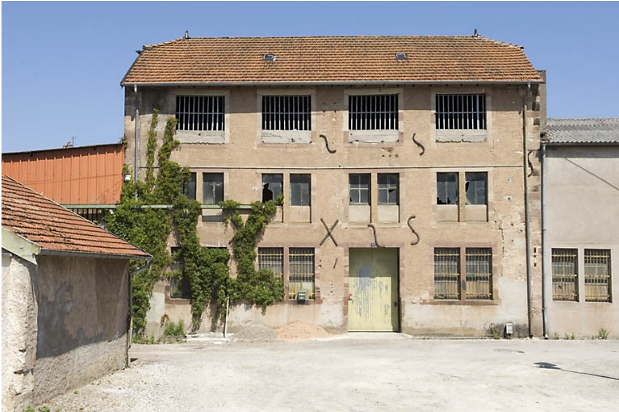
Façade sud du moulin à papier.
