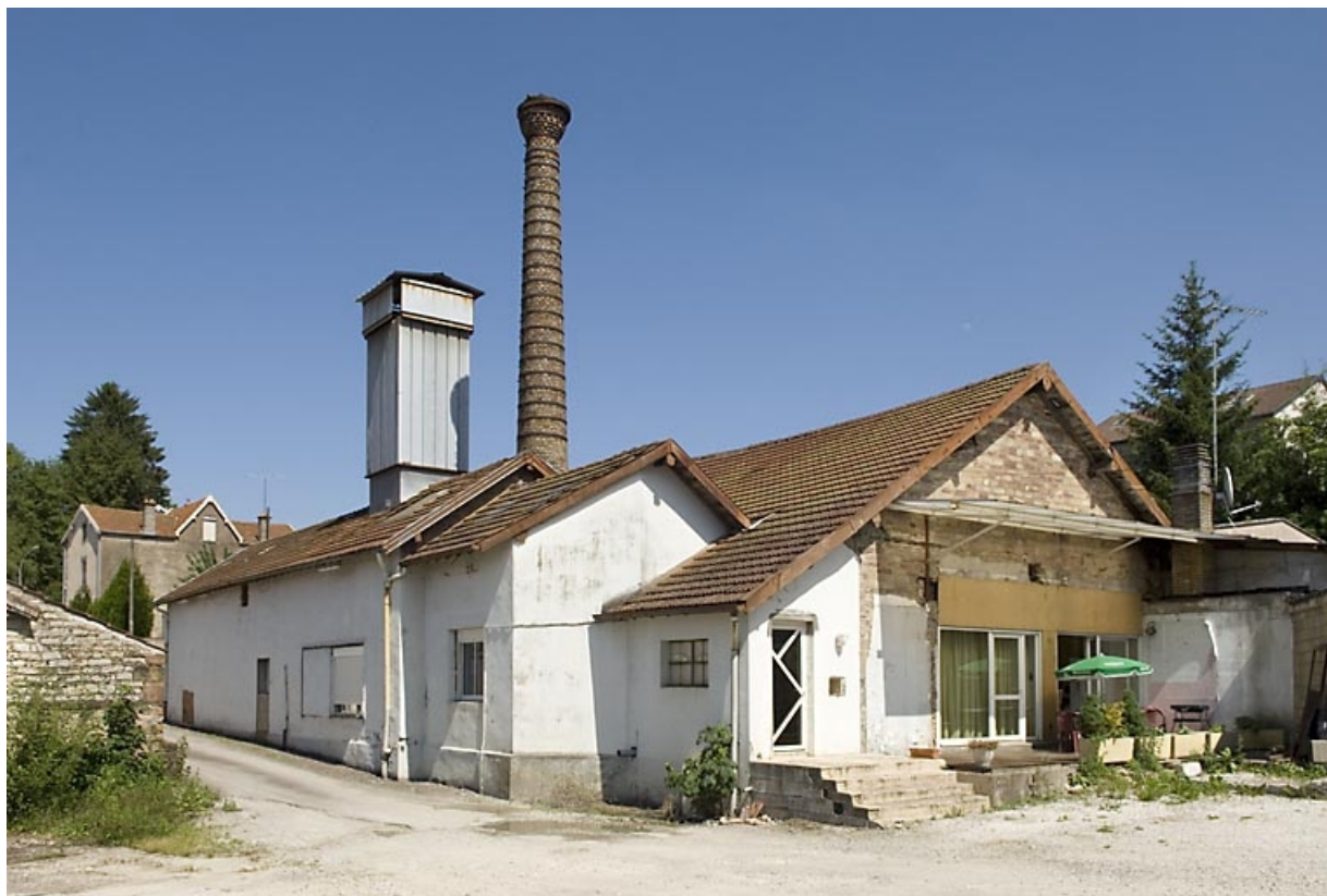
Vue depuis l'ouest.
