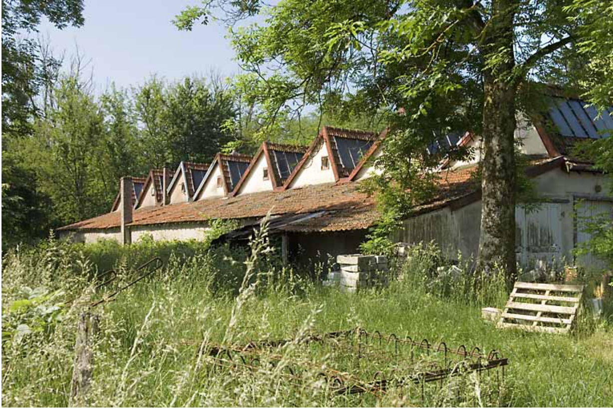
Pignons ouest de l'atelier de fabrication.
