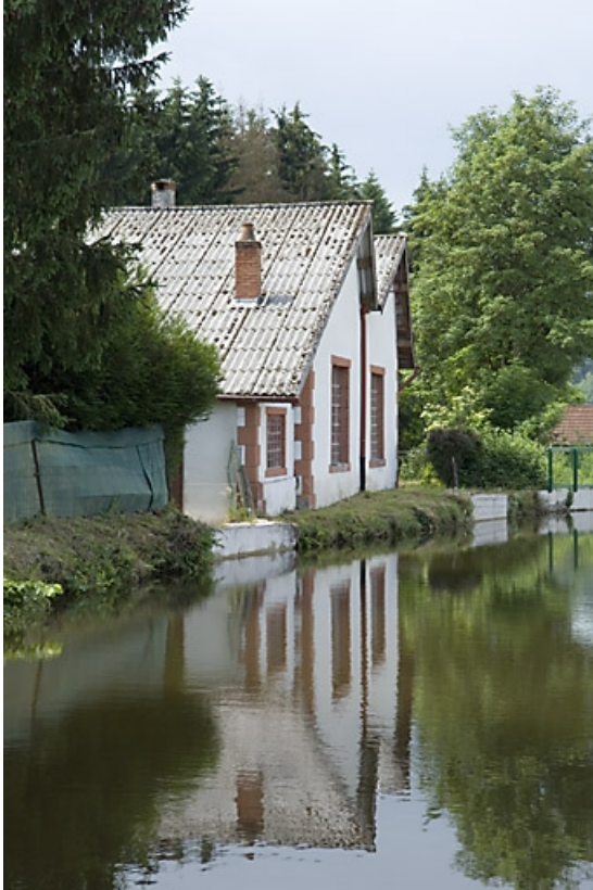
Atelier de réparation sur le bief d'amenée.
