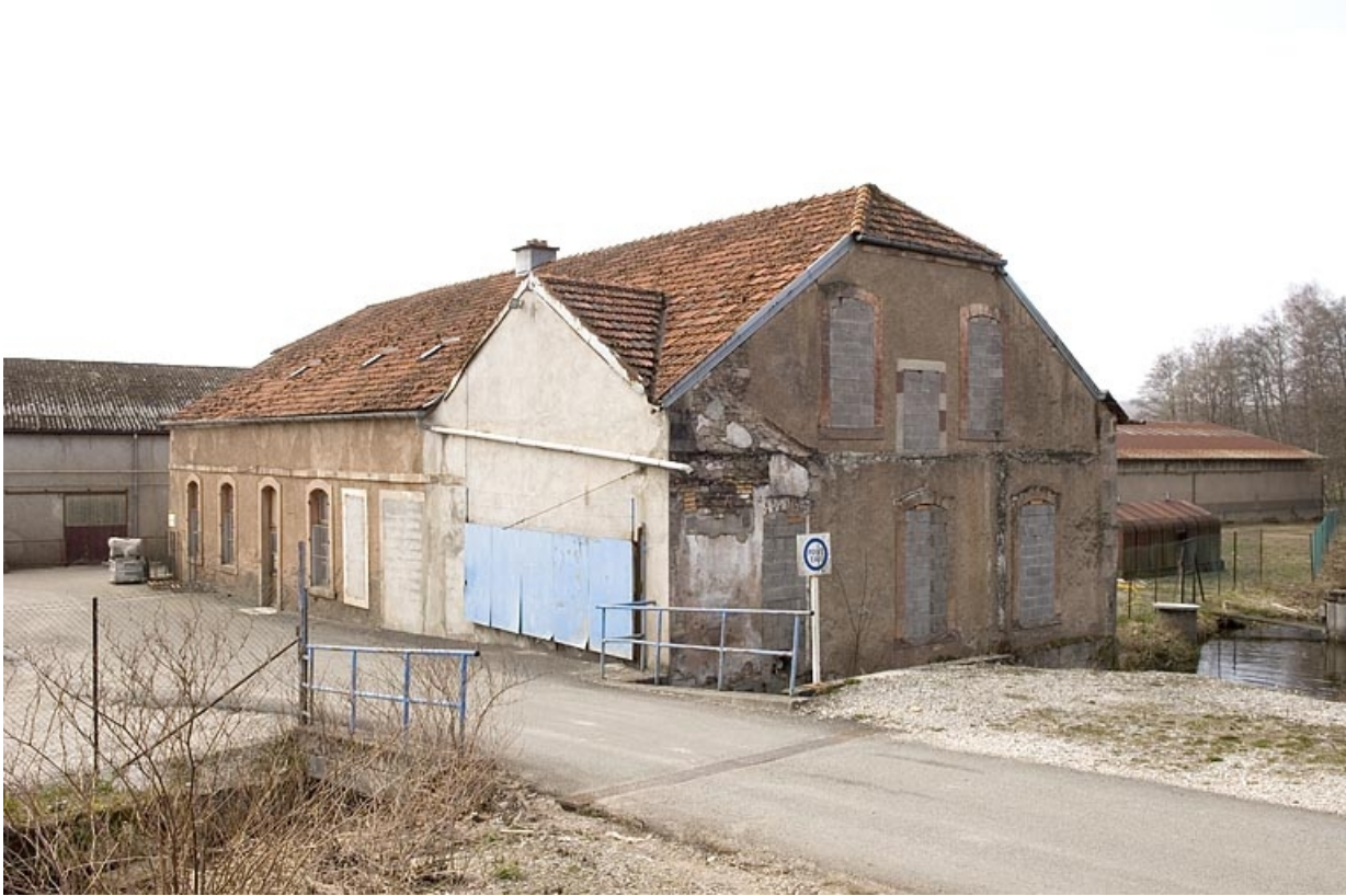
Moulin d'aval. Vue depuis l'est.
