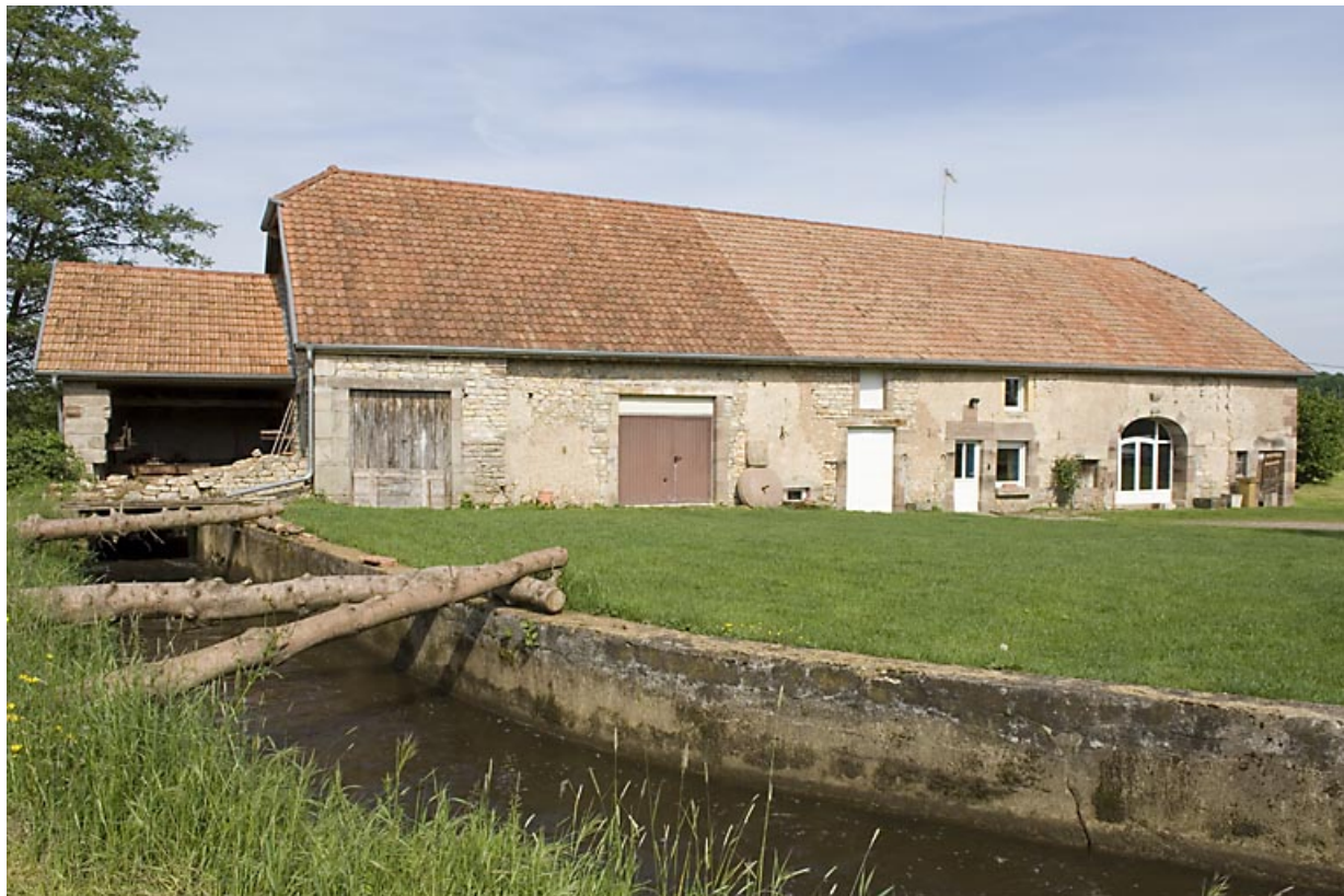
Bief d'amenée et façade antérieure.
