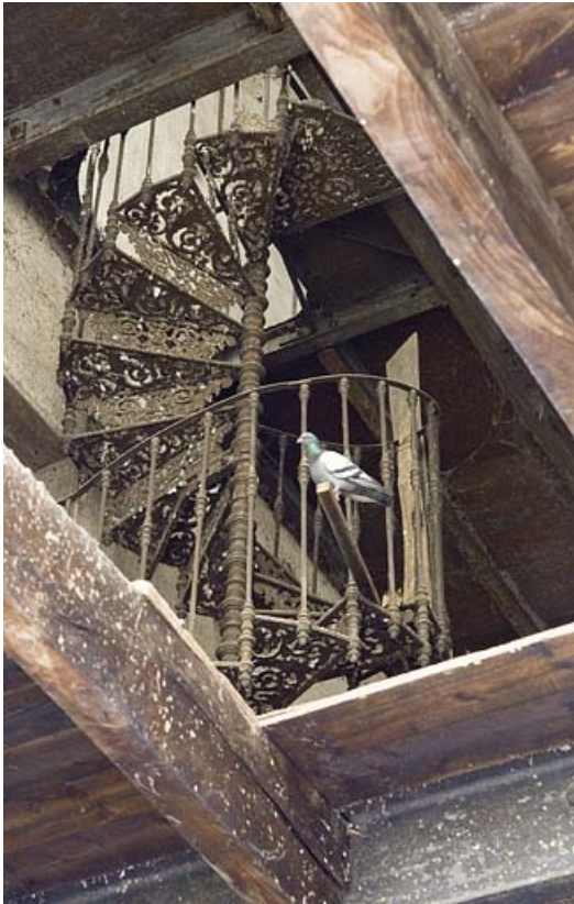
Bâtiment de rectification. Escalier intérieur en fonte. 70, Fougerolles, 20 Grande-Rue
