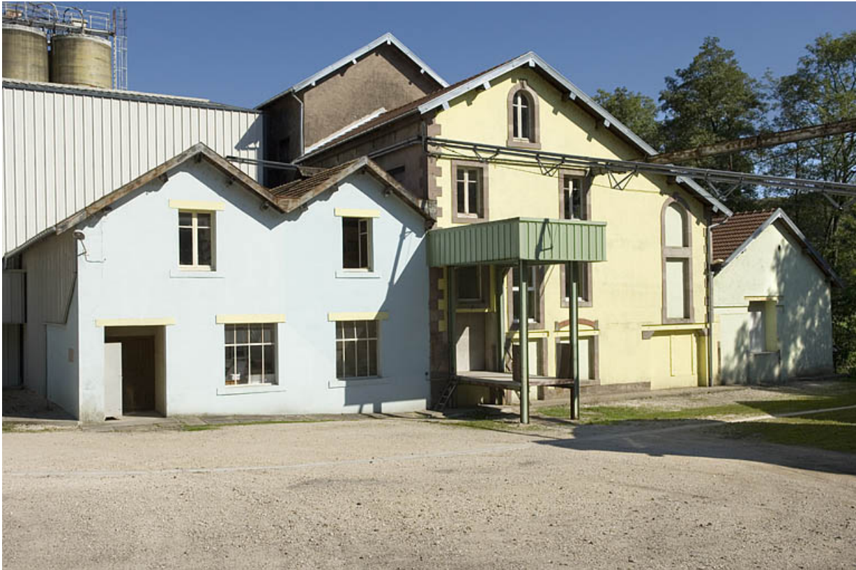
Façades occidentales du moulin.
