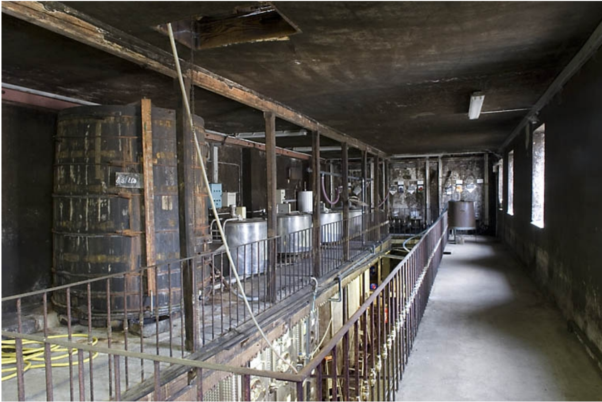
Etage de la cuverie (partie ouest).
