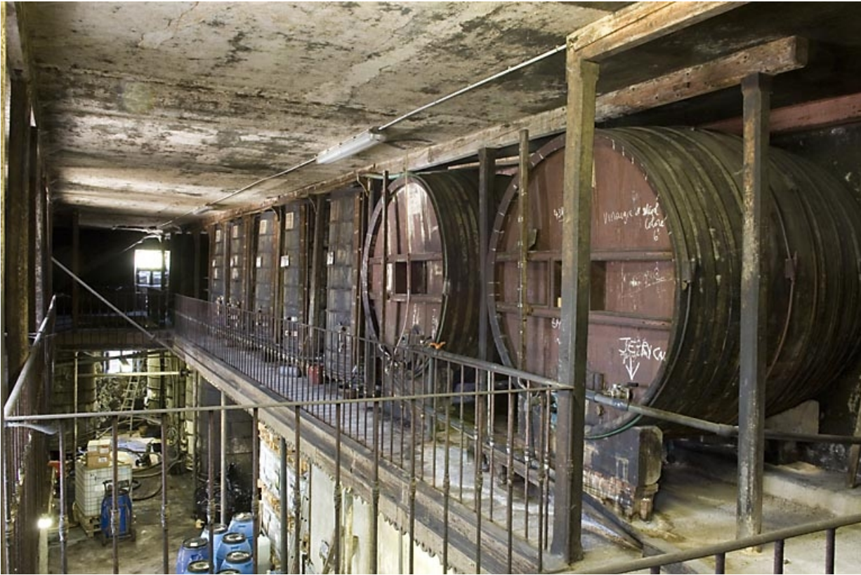
Etage de la cuverie (partie est).
