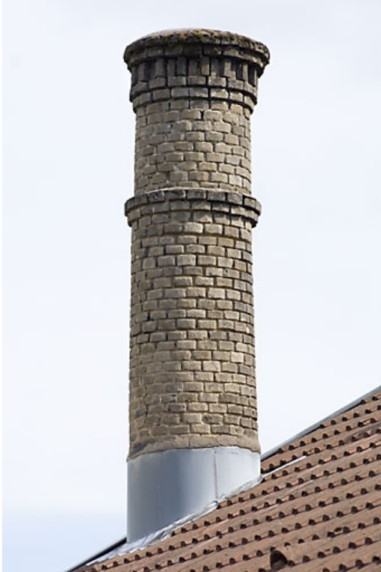
Détail de la souche de la cheminée.
