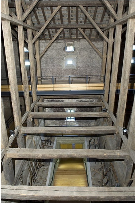
Charpente du fenil. travée centrale.
