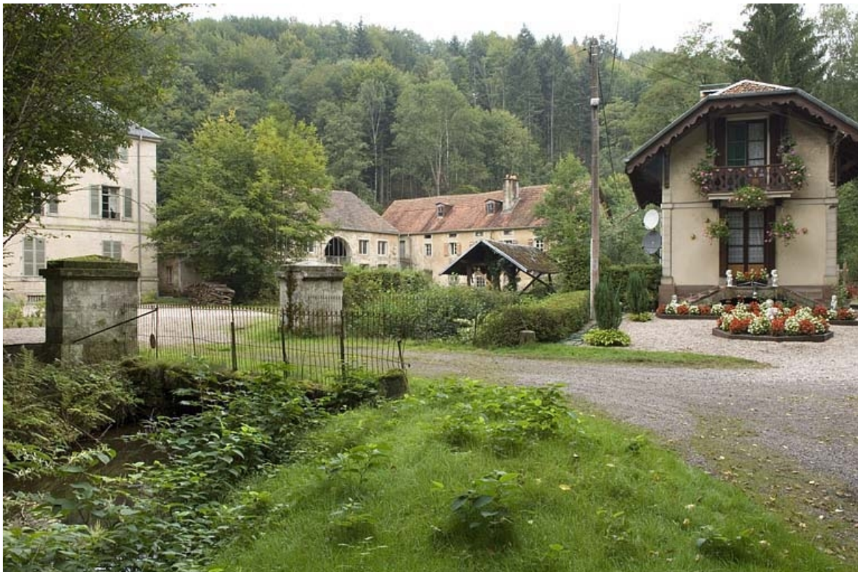
Vue d'ensemble depuis l'entrée.
