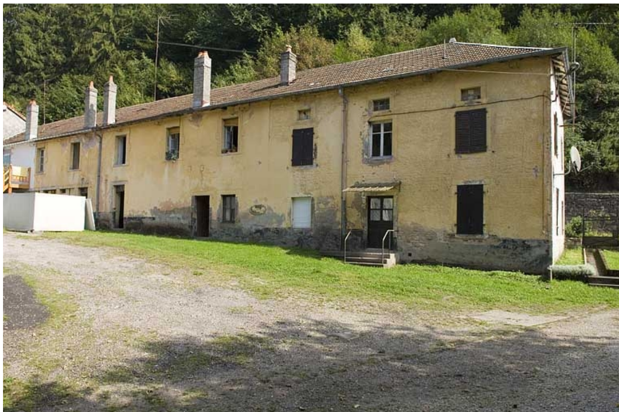
Façade occidentale des logements ouvriers.
