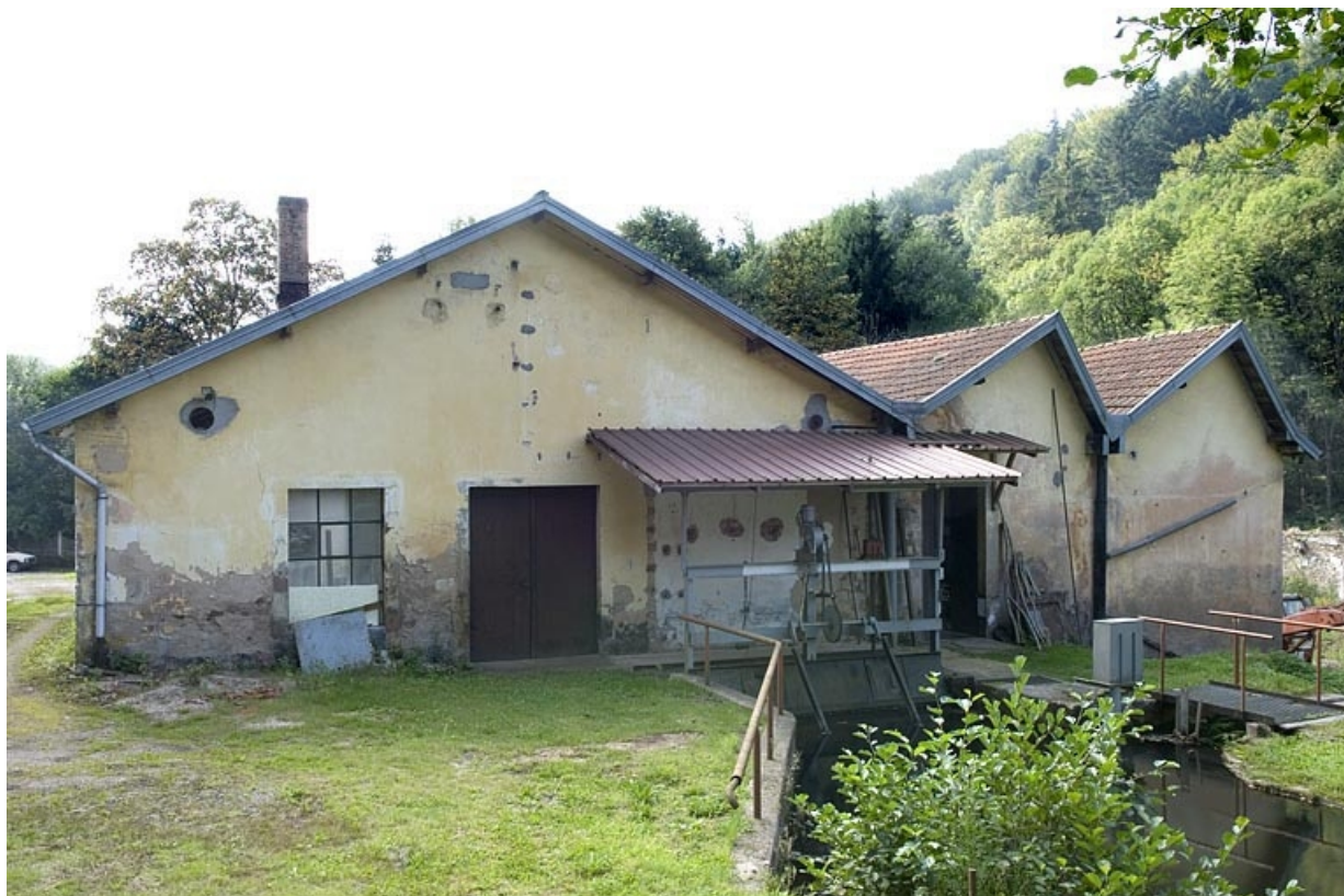
Pignon nord de l'atelier de fabrication.
