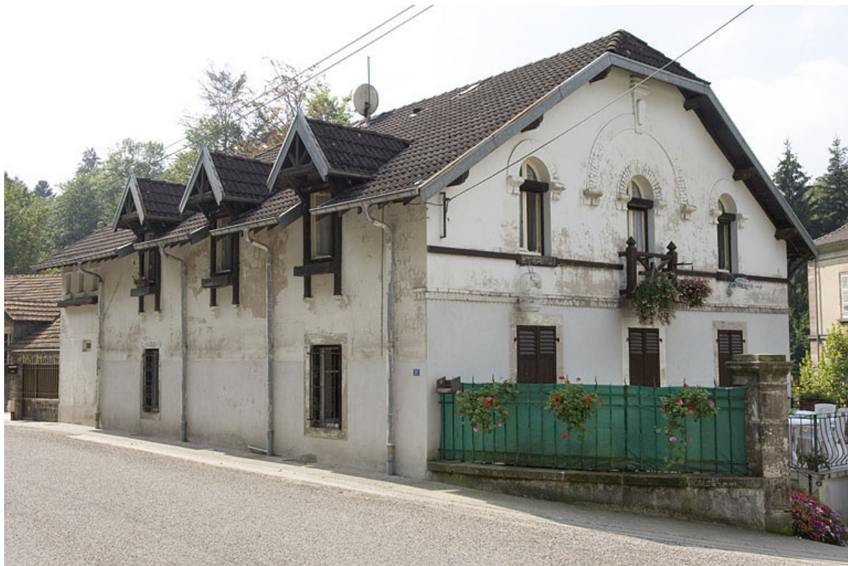
Logement du directeur. Vue depuis la route.
