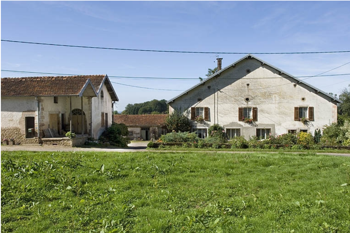
Bâtiments industriels et pignon de la ferme.
