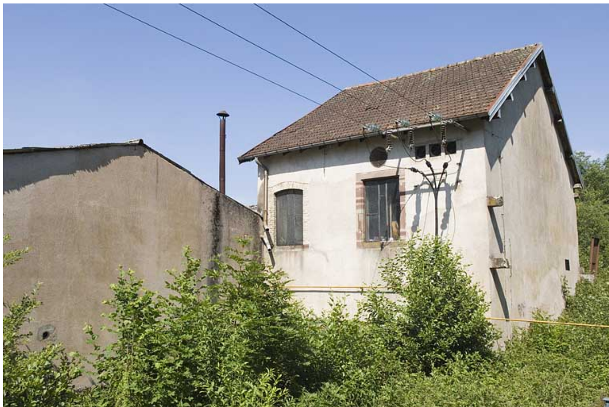
Bâtiment d'eau, actuellement transformateur.
