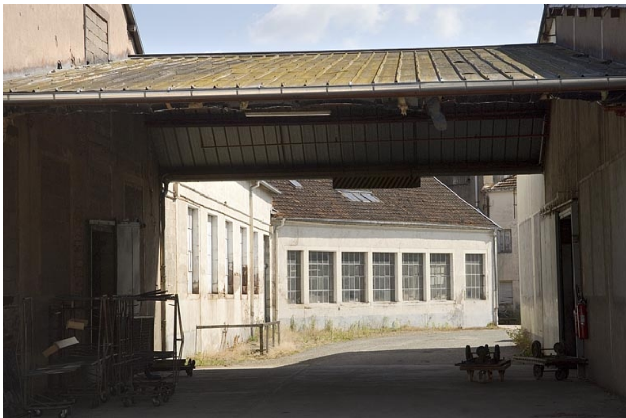
Atelier de fabrication original. Vue depuis l'ouest
