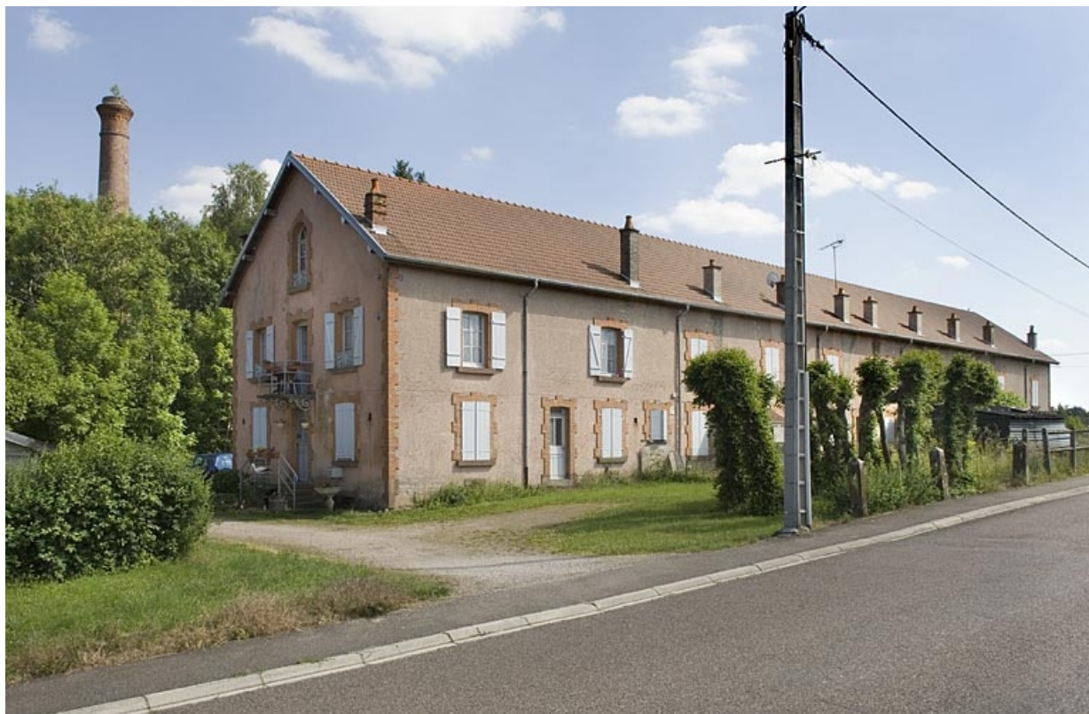
Logement ouvrier dit cité Saint-Anne.
