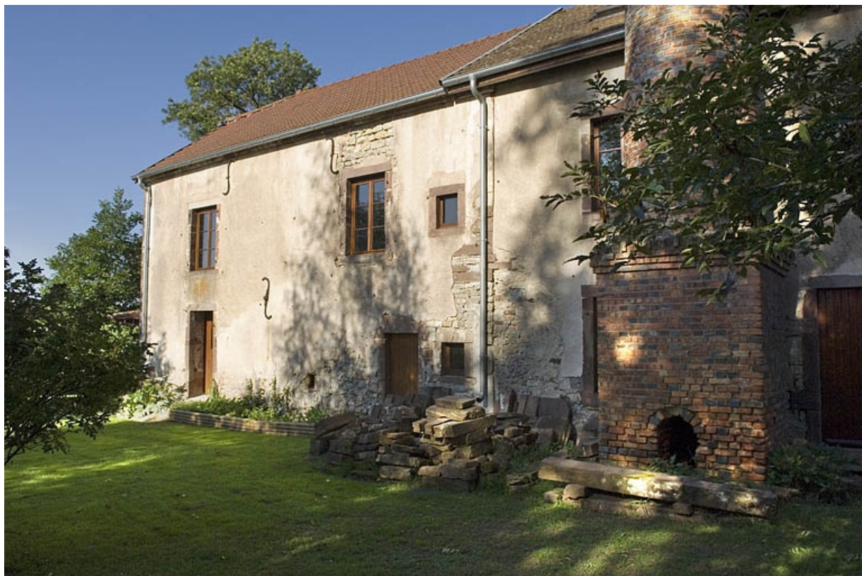
Partie sud (logement) de la façade postérieure.
