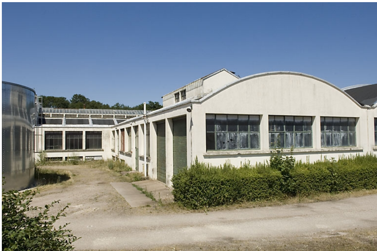
Détail d'un atelier de fabrication.
