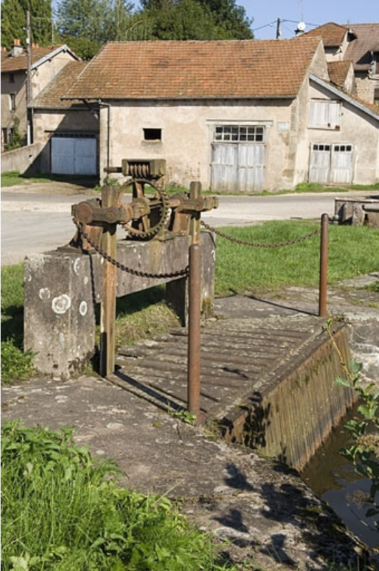
Vanne de prise d'eau de l'étang.
