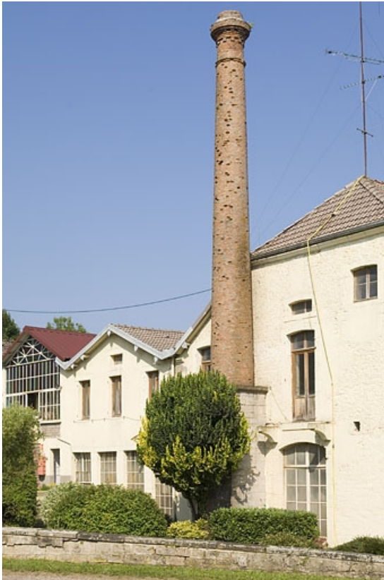
Façade est des ateliers et cheminée.
