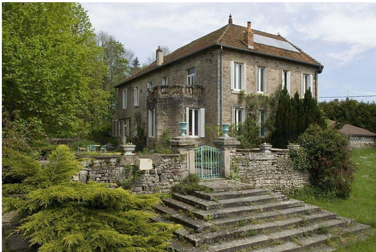
Logement patronal vu de trois quarts.
