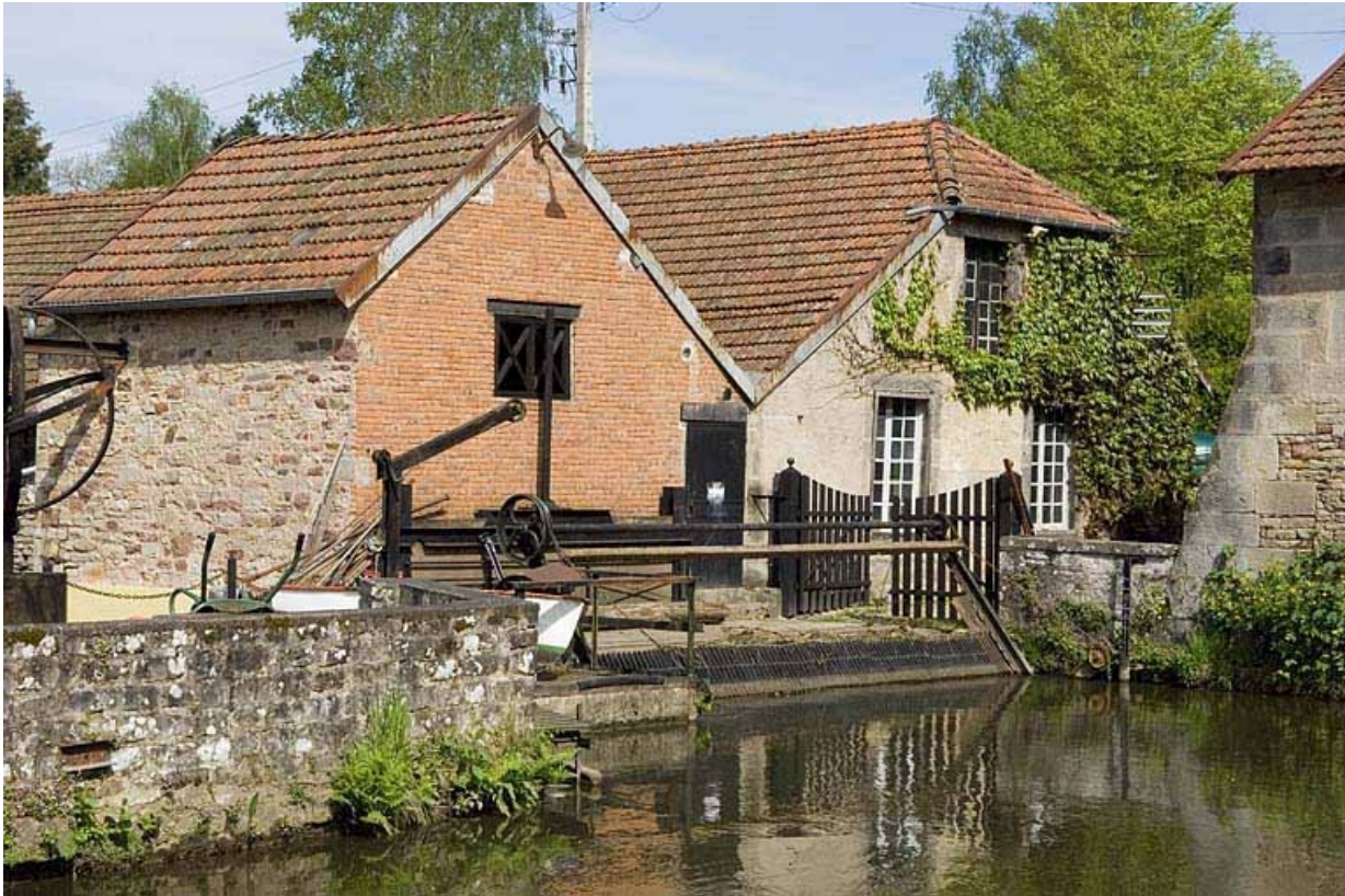
Salle des machines (nord).
