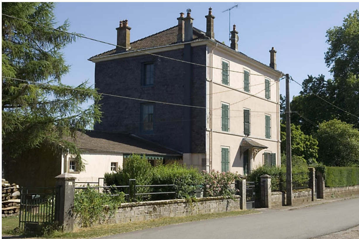
Logement patronal sud. Vue de trois quarts.
