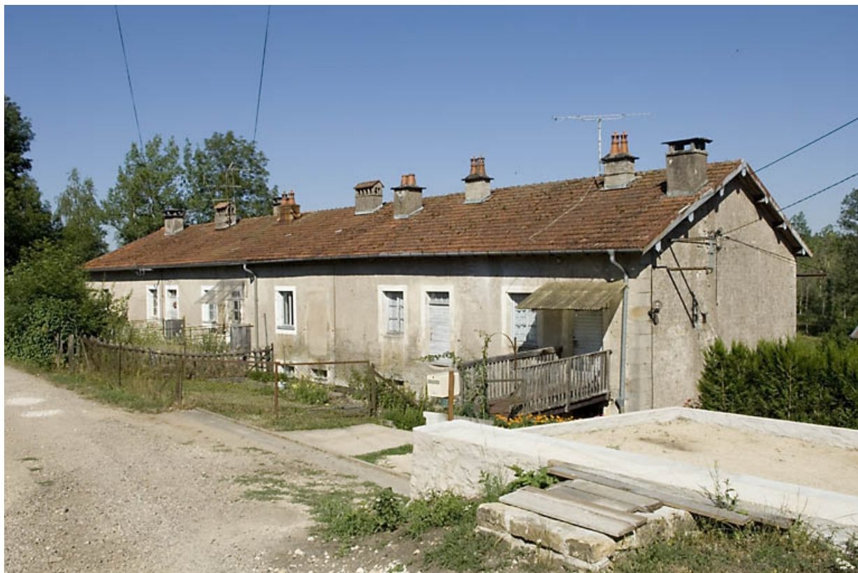
Logement ouvrier collectif (impasse Albert Ricot).
